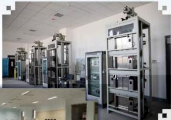
智能电梯安装调试 维护训练场所
